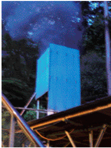
炎が飛び散らないように囲った煙突
